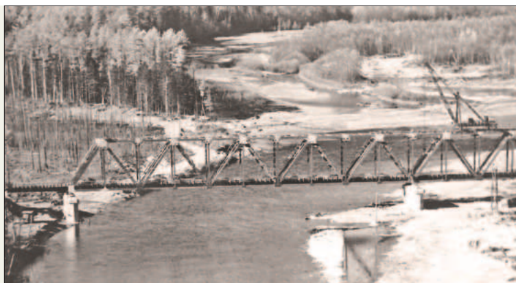
📍 Монтаж моста через Амгунь
