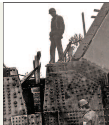
📍 Бригада на монтаже моста
